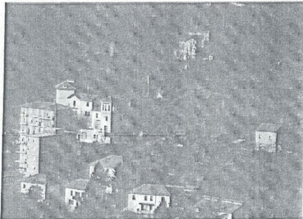
fotografia dello stato attuale
